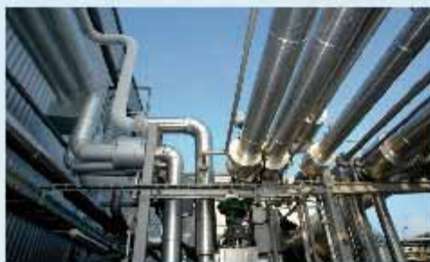
管路供應方案 Pipeline Distribution
