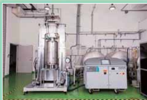
超高壓水設備
